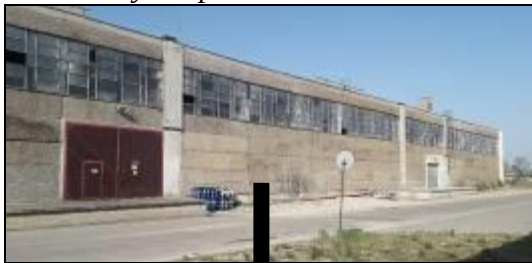
Budynek pod adresem 87B
