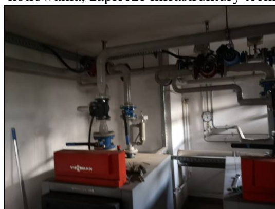
Widok wewnątrz budynku – część gospodarcza – kotłowania – piece na olej
