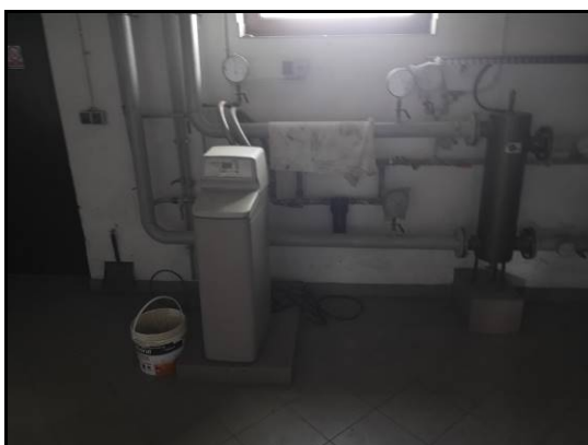
Widok wewnątrz budynku – część gospodarcza – stacja uzdatniania wody
